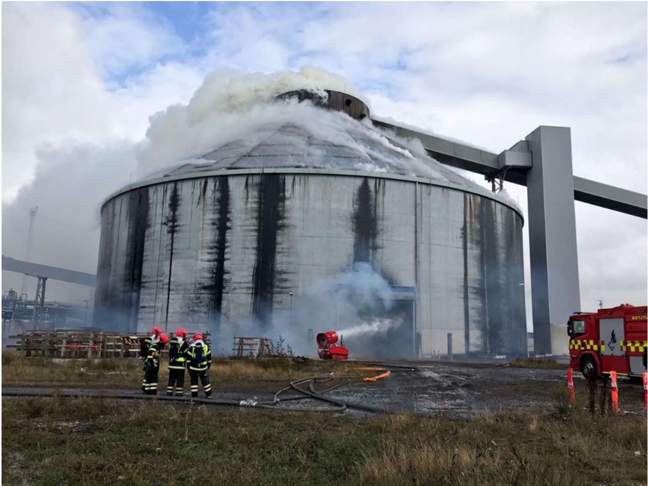
Beredskabsstyrelsen deltog i fire uger i slukningsarbejdet af den omfattende brand ved Studstrupværket.
