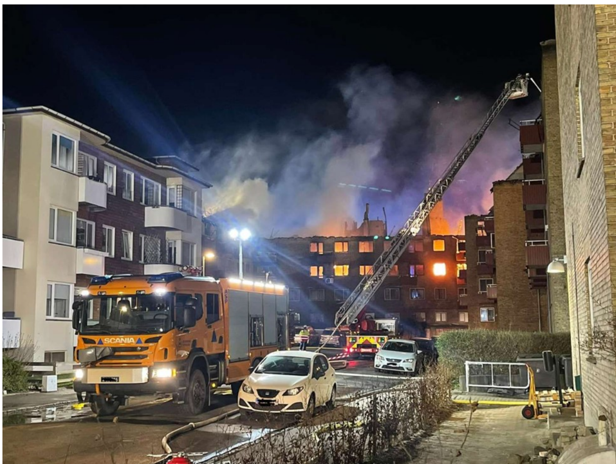
Brand i et boligkompleks i Vanløse.
