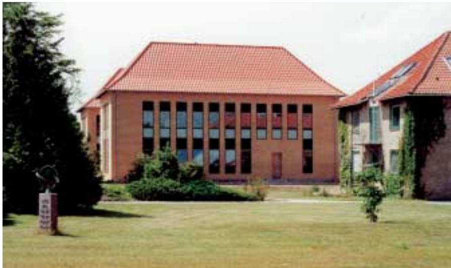
Varde Kaserne. Hærens Artilleriskoles nye stabsbygning er opført i sammenhæng med den gamle stabsbygning. Foto: Forsvarets Bygningstjeneste.
